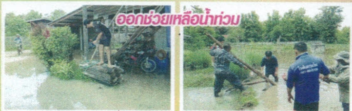
สูบน้ำช่วยเหลือน้ำท่วม ม.3
