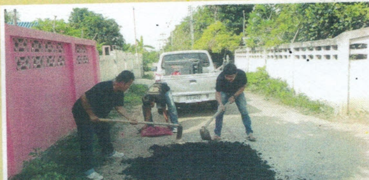
ซ่อมแซมถนนในหมู่บ้าน
